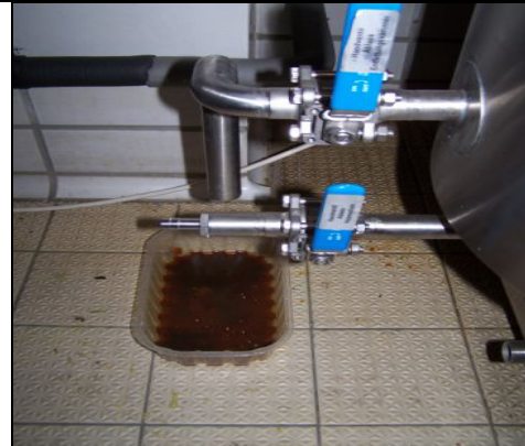
Beheizter Ausgang für Knochenfett seitlich der Anlage. Leicht zugänglich und effektiv.
